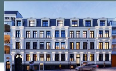
Widok na budynek od frontu
