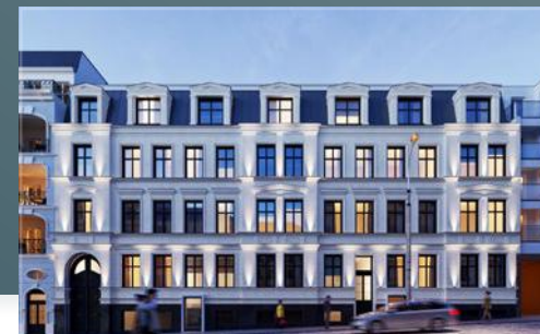
Widok na budynek od frontu
