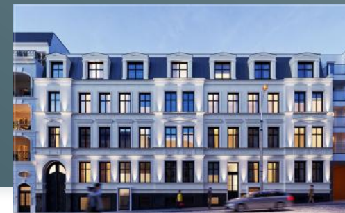
Widok na budynek od frontu
