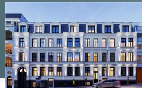
Widok na budynek od frontu
