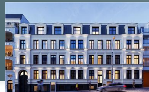
Widok na budynek od frontu
