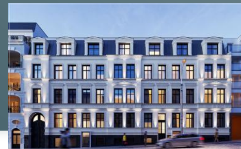
Widok na budynek od frontu
