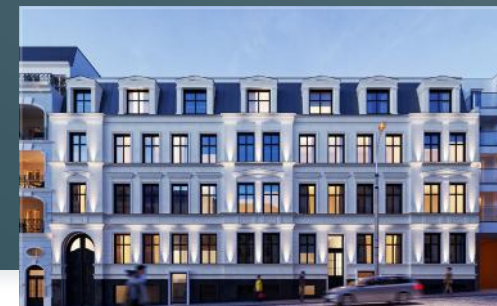
Widok na budynek od frontu
